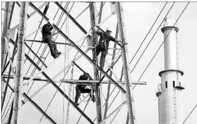
Torres de alta tensión en el Besós.
